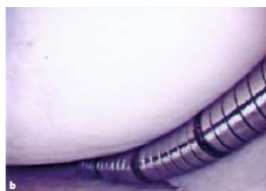
Фиг.30 Определяне размера на дефекта.
